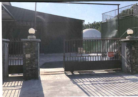
祥圃實業為擴大經營而接手了歷史近30年、位於南投的新合興牧場。當時為改善廢水處理問題和汰換老舊設備，進行大規模翻修工程。
