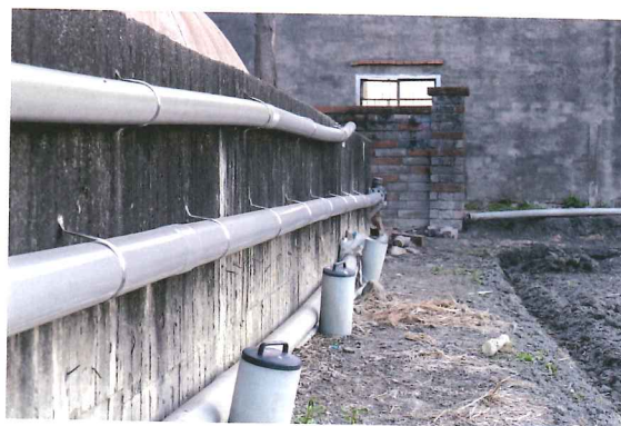
將厭氧發酵後生成的沼氣收集起來，再用管線導入畜舍，作為沼氣保溫燈燃料。
