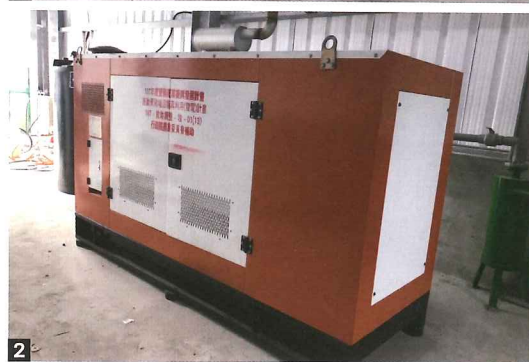
1 圖為曝氣處理設備。讓空氣通入廢水，增加裡頭的溶氧量，以利好氧菌分解水中的殘餘有機質。 2 圖為小型的沼氣發電設備系統。關於沼氣發電，包括行政院農業委員會、環境保護署以及經濟部能源局都有相關補助。
