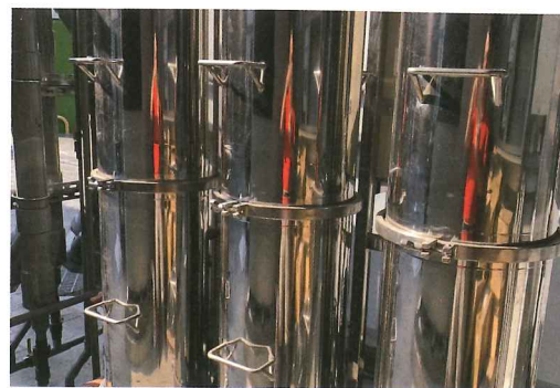
左圖為脫硫設備，將沼氣中具有腐蝕性的硫化氫去除。右圖為發電機面板。
