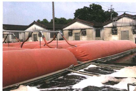
臺灣養豬場設置三段式廢水處理設備的普及率極高。圖為厭氧發酵設備紅泥沼氣袋，打入空氣的曝氣池為好氧處理。
