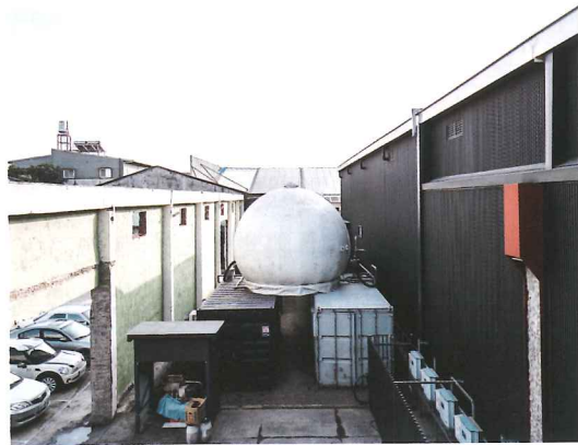
良作工場旁的小型兩段式厭氧發酵設備，利用肉品分切後的下腳料結合廚餘展開共消化實驗，試圖找出更高的沼氣產生方法。
