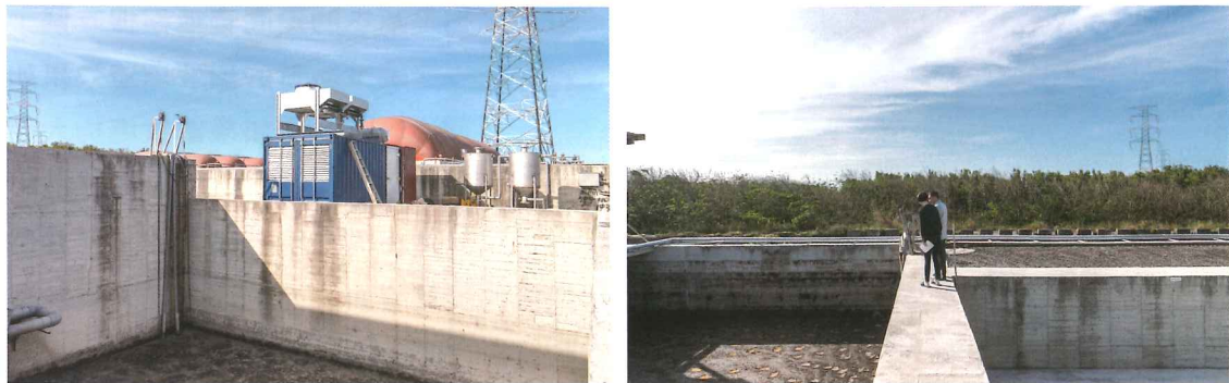
集美牧場採用三段式廢水處理，圖為場內設備景觀。
