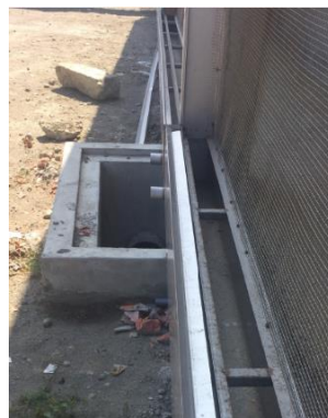
雨廢水分流 完工照片
