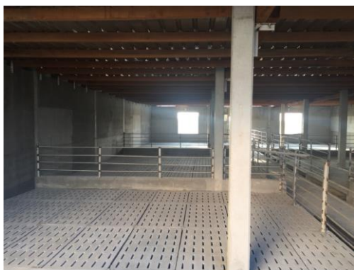
高床設施 完工照片
