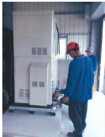
沼氣發電相關設備(施) 設置中照片
