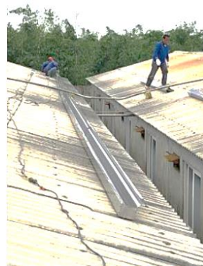
雨廢水分流 設置中照片
