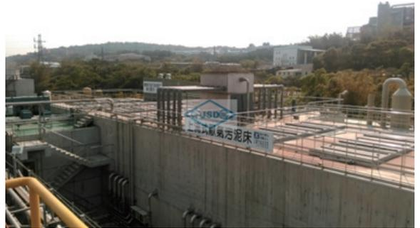
UASB上流式厭氧污泥處理系統
