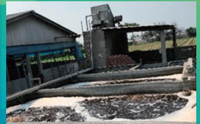
利用液體與氣體泵將空氣打入水體，提高水中溶氧量以供應好氧微生物生長，促使好氧微生物分解有機廢水，達到淨化水質之目的。
