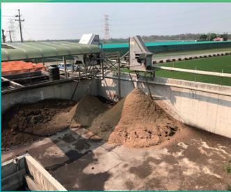
利用固液分離機或欄柵去除廢水中固形物，減少有機質進入廢水處理系統，減輕處理系統負擔，另一方面可減少槽體淤積，提升槽體使用壽命。
