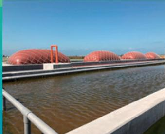
槽體經過密封與大氣隔絕形成缺氧環境，此環境有助於厭氧微生物生長並分解高濃度有機廢水，此階段可分解80%有機質且所需耗能最低。
