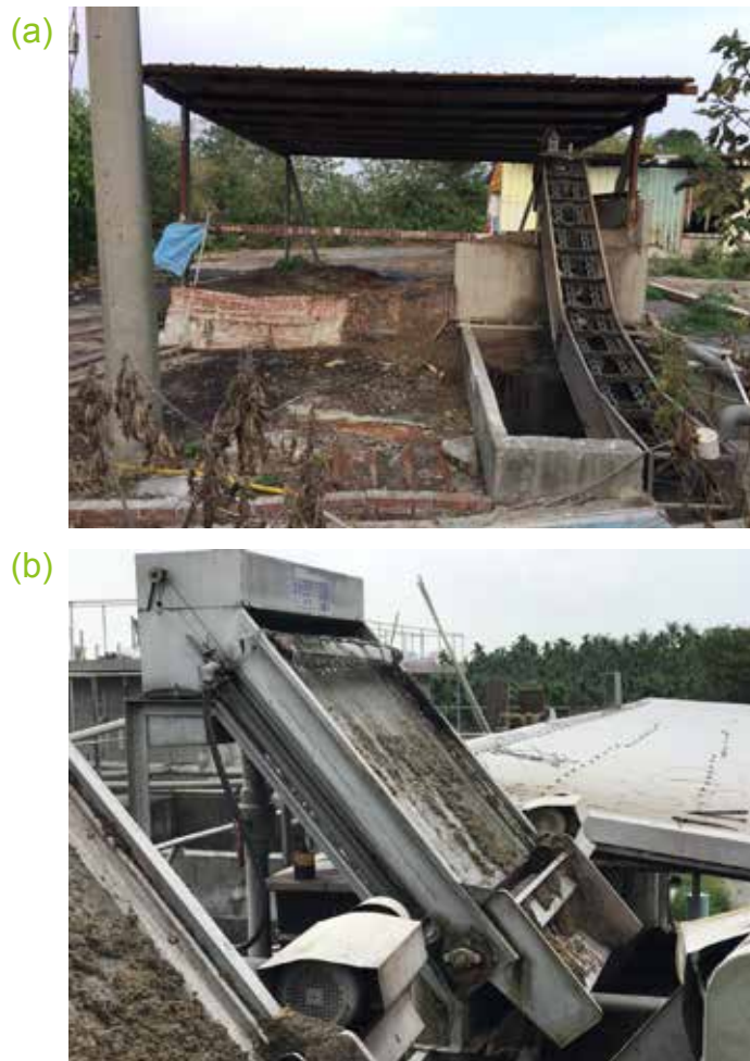
圖 2 (a) 水車式固液分離機；(b) 斜板式固液分離機
