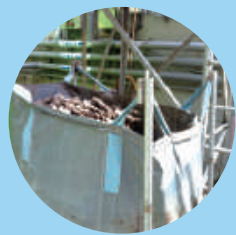
污泥收集設備
